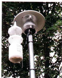
Abb. 5a: Helmleuchte vom Typ „Rondo“ mit Plastiksektor.
